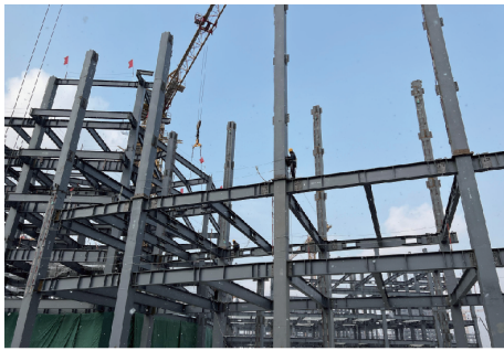
图6 通州区九年一贯制学校钢结构工程
