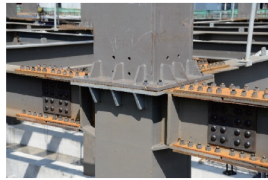
图2 新型钢框架全螺栓连接体系
